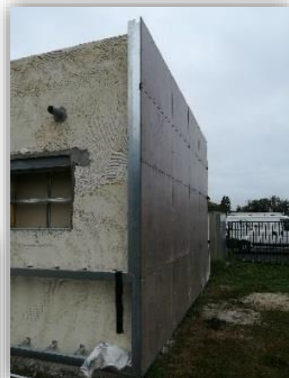
Travaux d'extension de l'ALSH de CASTELNAU- DE-MEDOC
