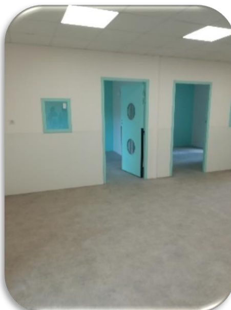
Remplacement du sol carrelé par un sol souple
