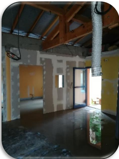
Restructuration de salles
