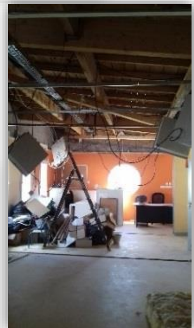
Travaux de réhabilitation de l'ALSH d'AVENSAN
