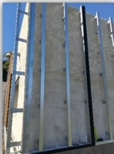
Travaux d'extension de l'ALSH de CASTELNAU-DE-MEDOC
